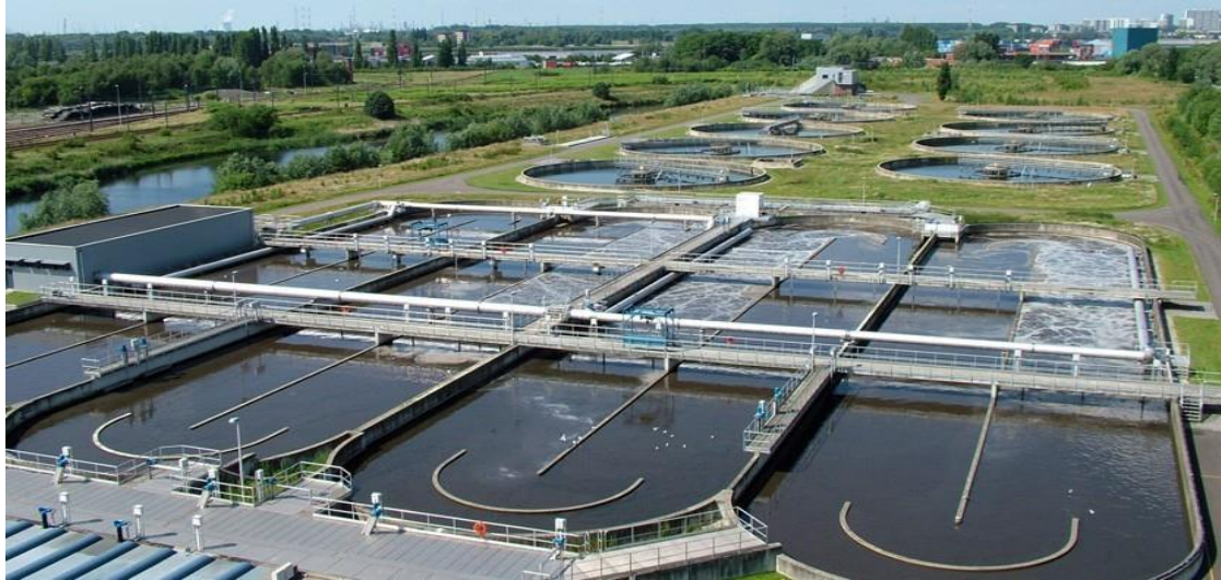
Figura 4. Planta de Tratamiento para Aguas n (PTAR) que ayudan a minimizar dicha problemática. Visión general de la planta de tratamiento de Antwerpwn-Zuid situado al sur deAmberes (Bélgica).
