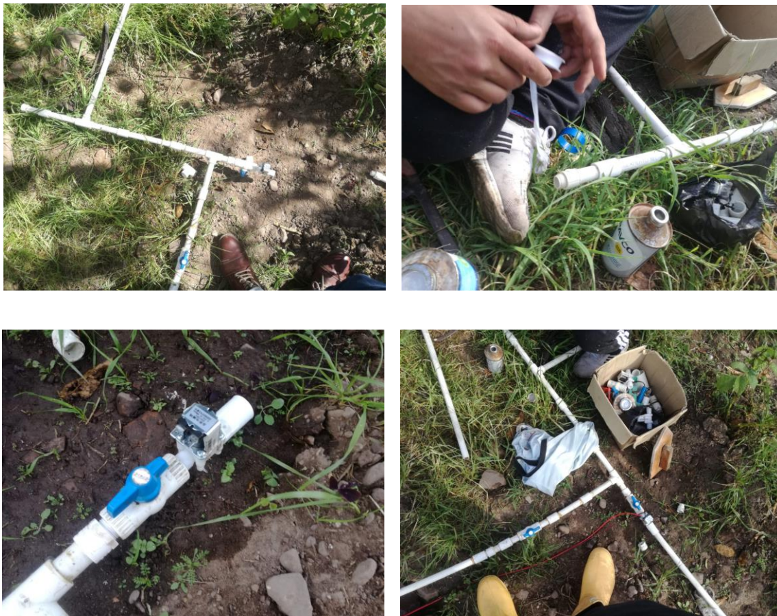
Ilustración 71. Implementación de tubería. Fuente: Autor.
