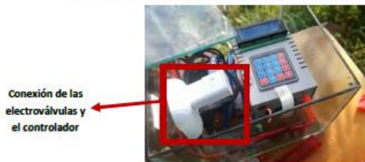
Fig. 6. Tablero de distribución.
