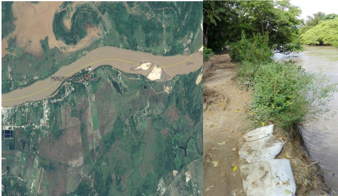
Ilustración 6 Vista General del Área Afectada.
