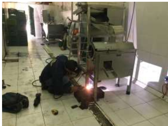
Figura 32. Aseguramiento de las máquinas al piso.
