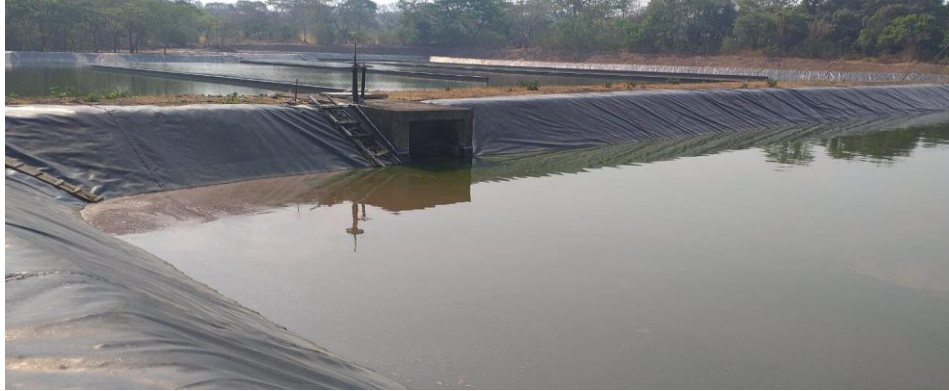
Ilustración 4. Laguna de oxidación PTAR Itivana.
