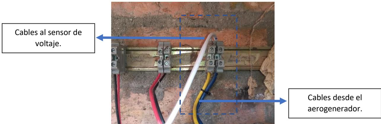
Figura 19. Bornera de conexión de la salida del aerogenerador con el sensor de voltaje.
