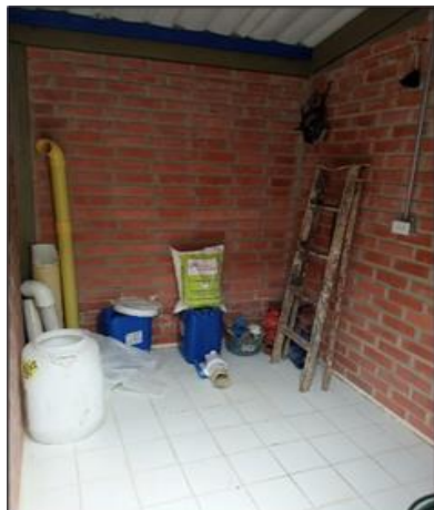
Ilustración 21 Falta de zona de descanso, escasos lugares para el descanso de los trabajadores
