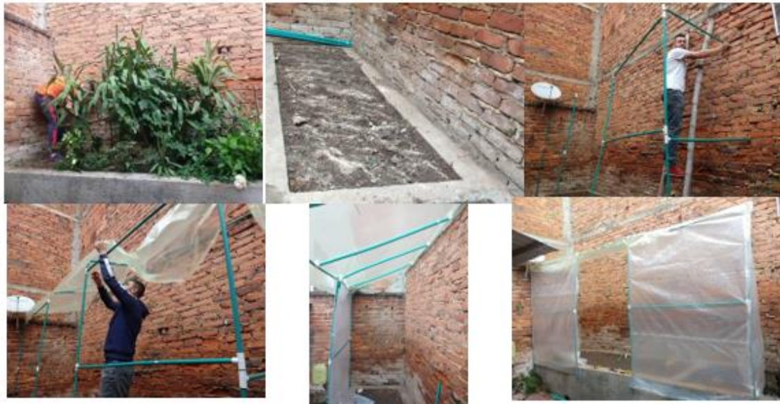
Ilustración 27. Construcción del invernadero en Pamplona [Autor]
