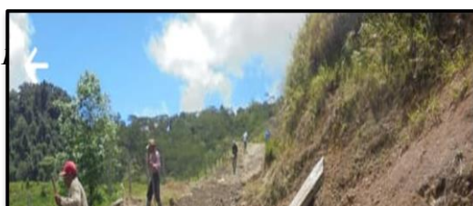
Obra Vial Toledo Riesgo falta de Elementos de seguridad
