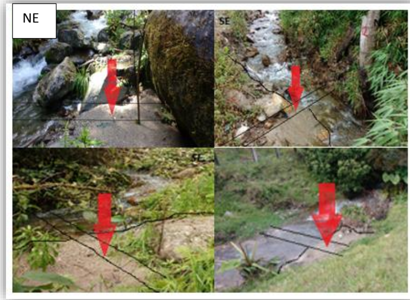
Fotografía 4. Sedimentos presentes en el cauce (margen derecho)
