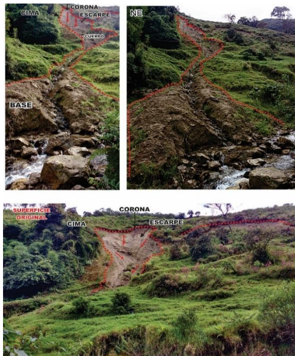
Imagen 11. Deslizamiento frente a los tanques desarenadores del acueducto del municipio de Chitagá
