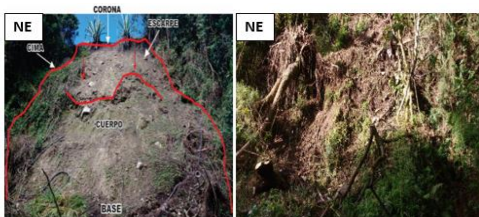
Imagen 12. Movimientos de tierra, que obstruyen parcialmente el cauce de la quebrada.
