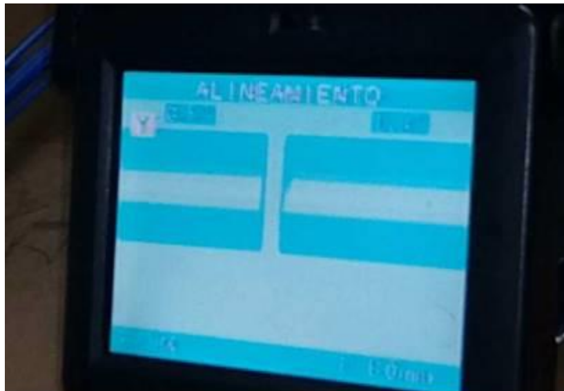
Figura 26. Empalme o Fusión de los hilos de fibra óptica
