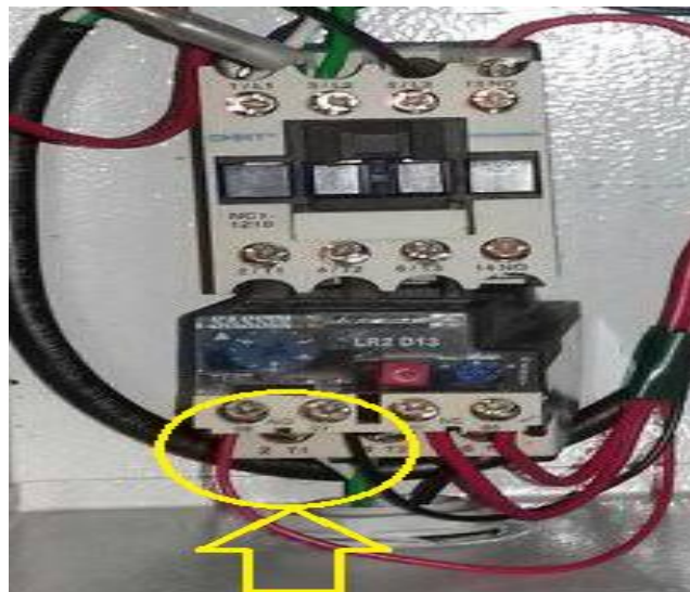
Fig. 38. Contacto normalmente abierto del relé térmico.
