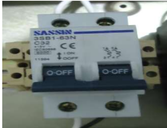
Figura 25. Foto de interruptor automático Fuente: Foto tomada por el autor
