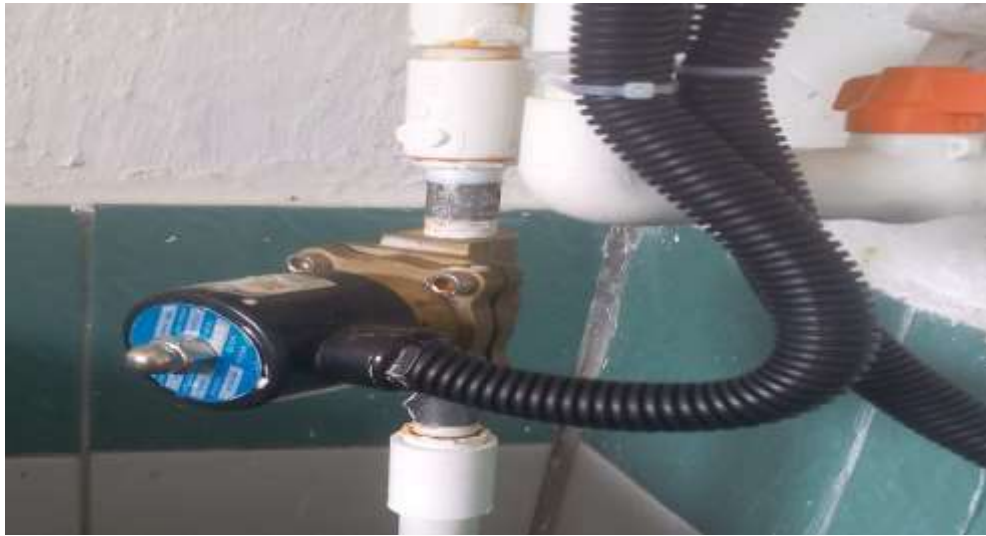
Figura 27 .Foto de la electroválvula. Fuente: Foto tomada por el autor.
