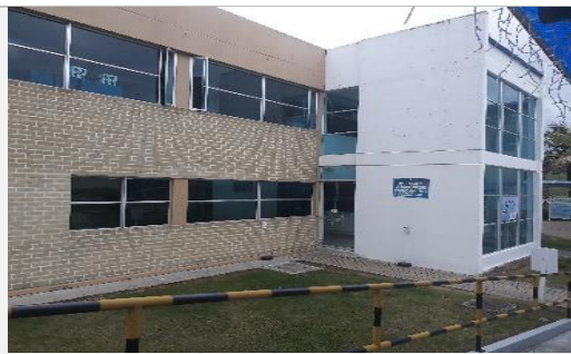
FIGURA 9. Edificio de Calidad Fuente: Autor del proyecto
