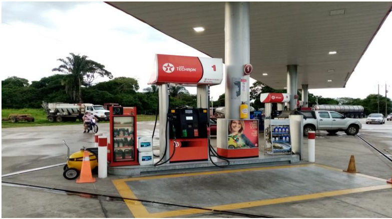
Ilustración 30. Unidad de suministro de combustible
