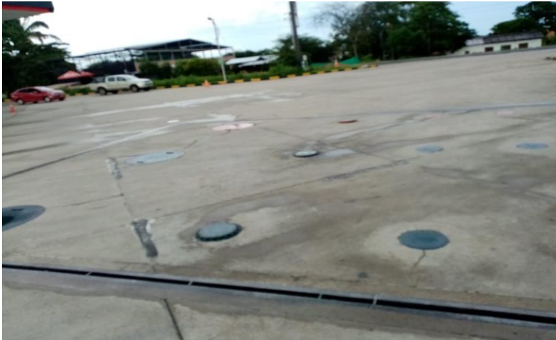
Ilustración 27. Almacenamiento subterráneo EDS Texaco
