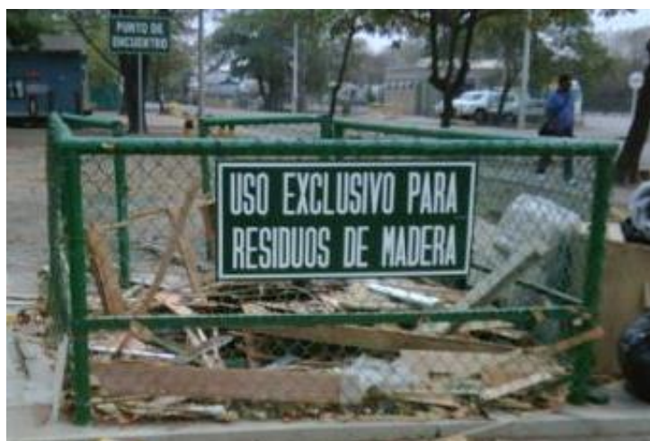
Ilustración 9. Almacenamiento de madera
