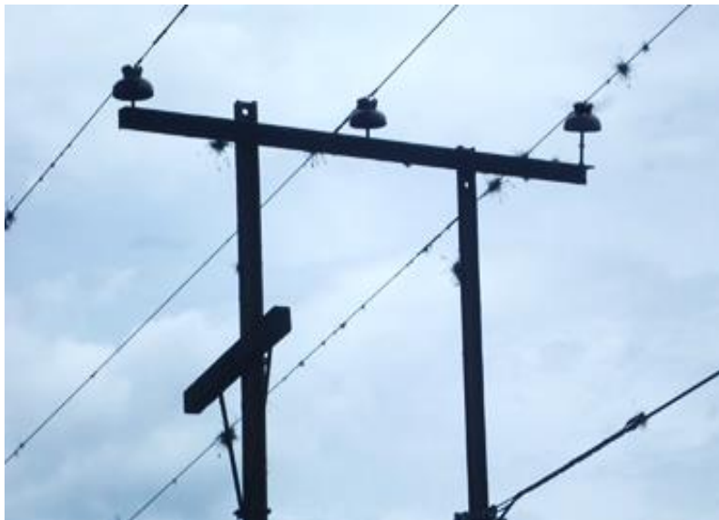
Figura 8. Estructura ICEL PH-202.
