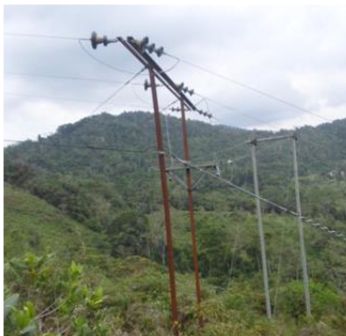
Figura 6. Postes de Madera.
