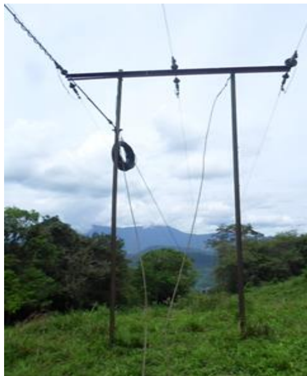
Figura 4. Postes de Riel metálico.
