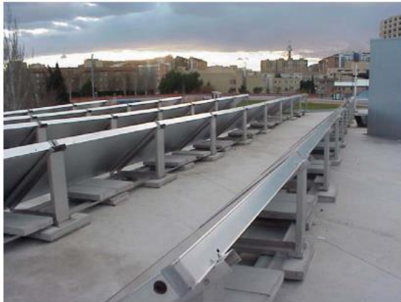
Ilustración 13. Contrapeso de hormigón en estructura para paneles
