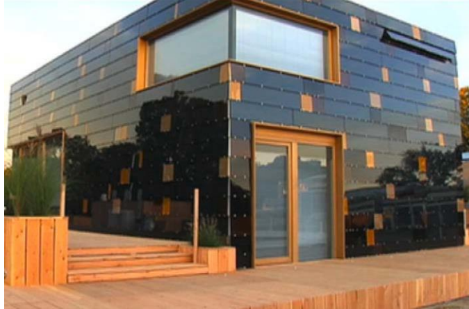
Ilustración 9. Ejemplo de integración alta en fachada
