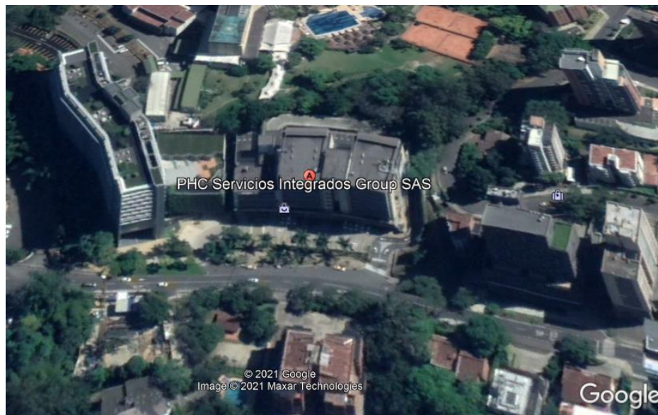
Ilustración 16 Panorámica de edificio Interplaza oficinas PHC
