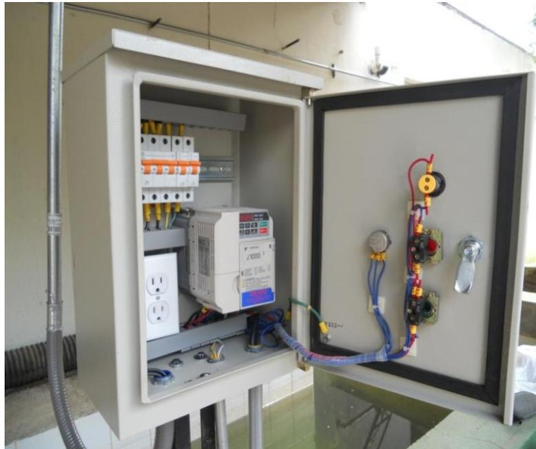
Ilustración 26. Sistema de control del secador. Autor.
