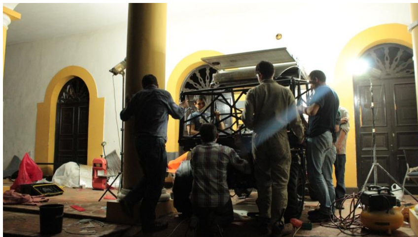
Fotografía 44, ensamble de la jaula de carga con el chasis
