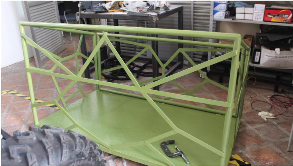
Fotografía 43, aplicación de corrosivo y pintura para jaula de carga
