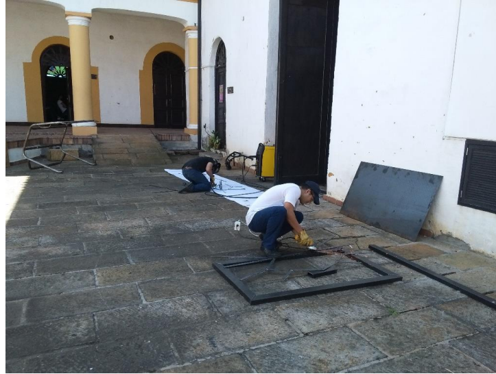
Fotografía 40, unión de jaula de carga.
