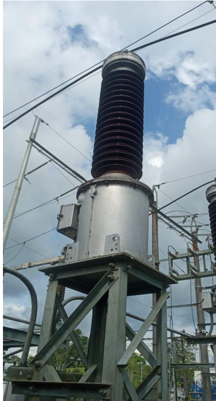
Figura 11. Transformadores de tensión capacitivos tipo CPA, condensadores de acoplamiento tipo CCA para voltajes del sistema 72,5 - 550 Kv. Fuente EEBP.
