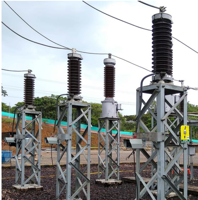
Figura 19. Descargador de sobretensiones de óxido de zinc EXLIM Q Clase 10 KA, según la clase de estación IEC. Fuente EEBP.
