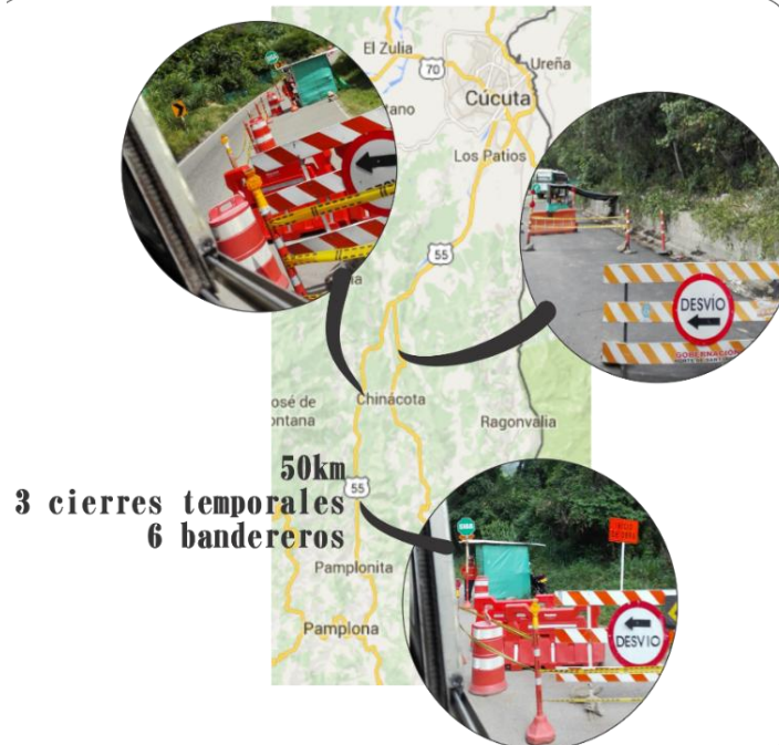
Ilustración 7 Cierres temporales en la vía Cúcuta- Pamplona
