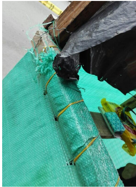
Ilustración 14 Ensamble de elementos de la estructura
