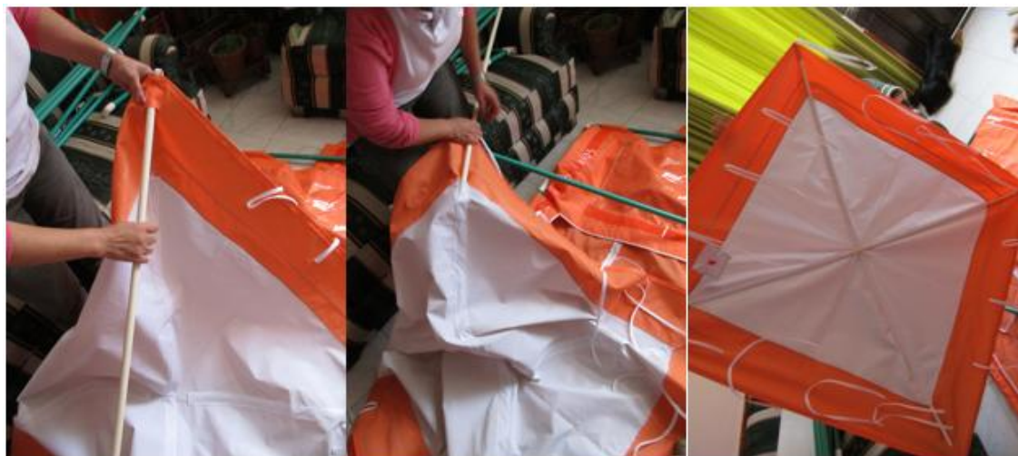
Ilustración 31 Armado de cubierta-techo
