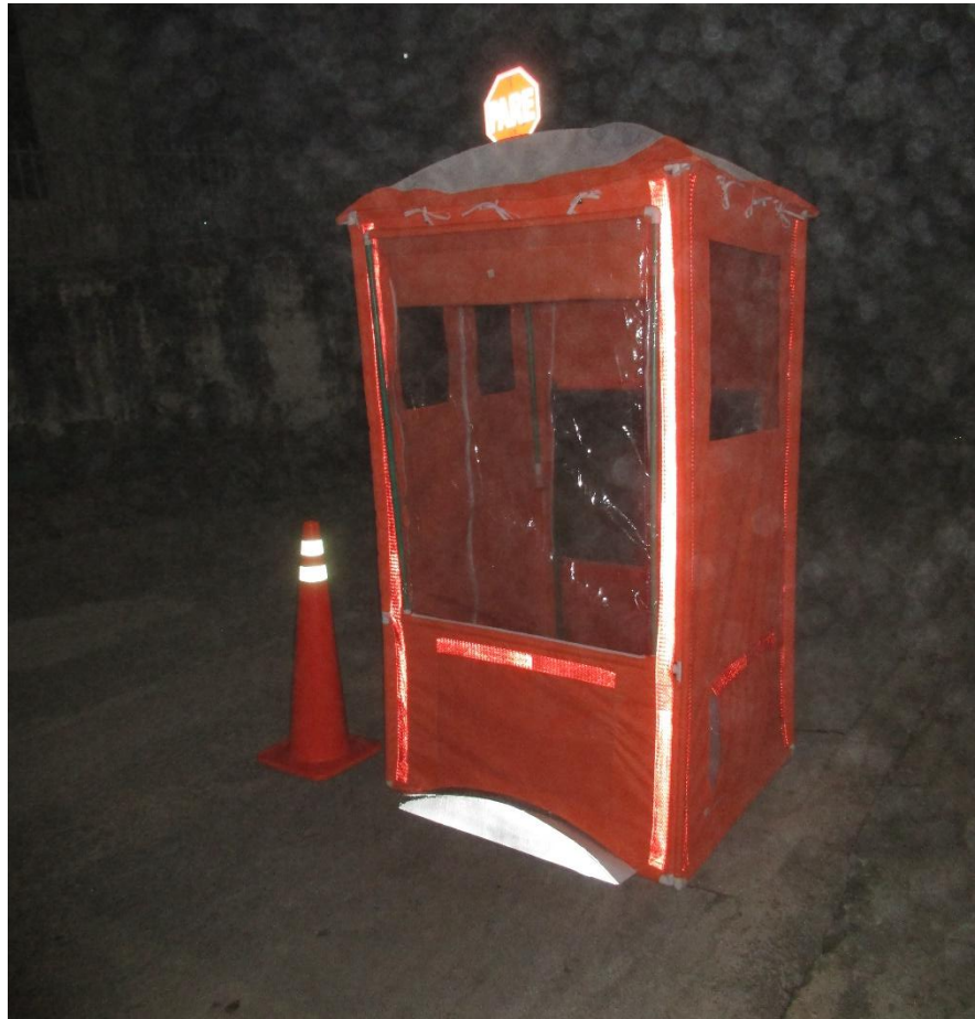
Ilustración 51 Funcionamiento de los elementos reflectivos del puesto de trabajo.
