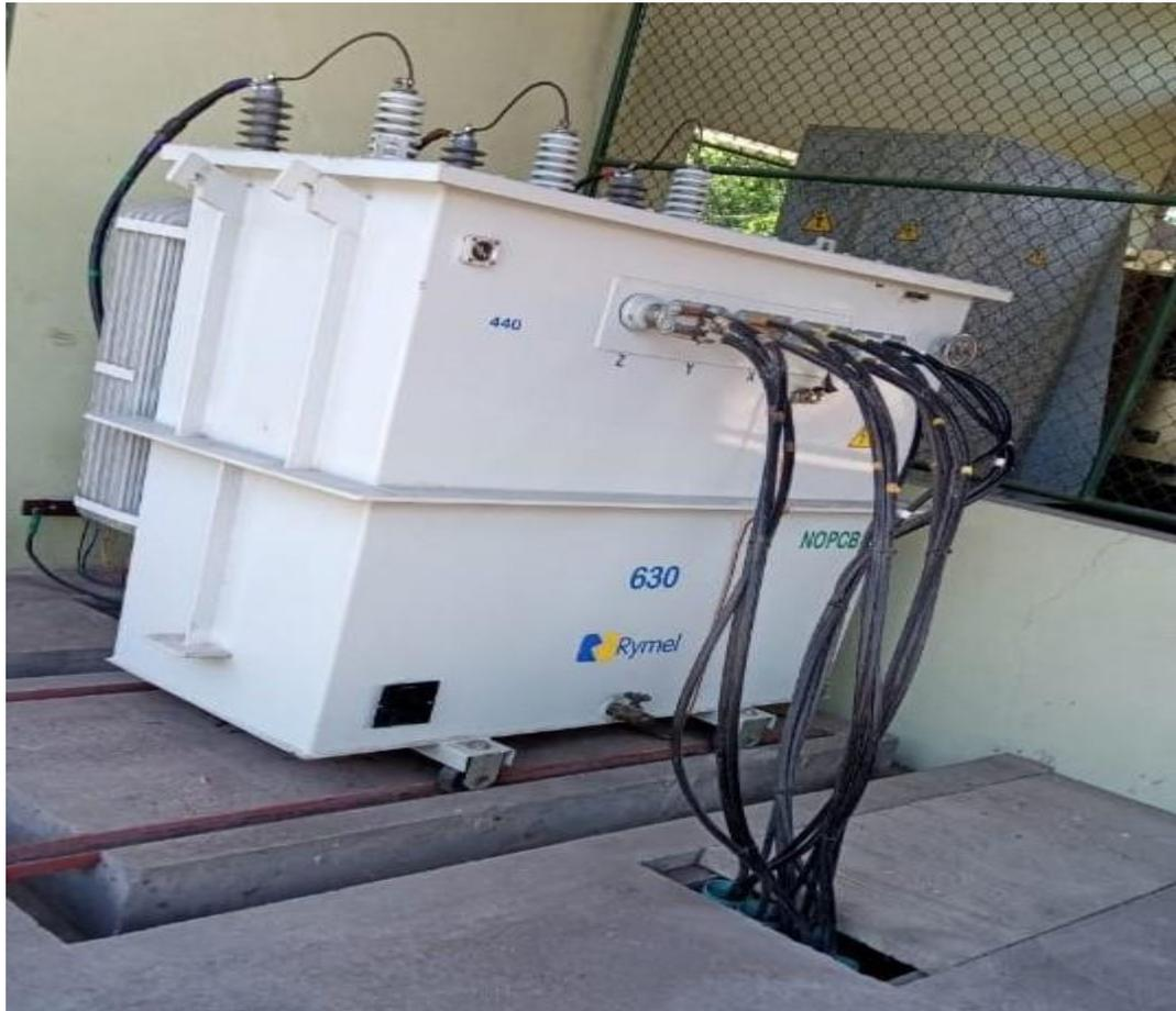
*Figura 6. Transformador Trifásico Rymel de 630 KVA 13.2 KV/440-254 V. Fuente Palmacará Ltda.*
