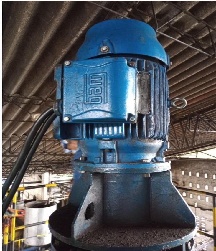
Figura 8. Motor trifásico WEG 30 HP 220/440 V. Fuente Palmacará Ltda.
