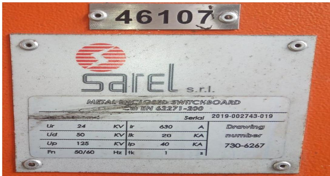
Figura 11. Placa característica de la celda de seccionador bajo carga. Fuente Palmacará Ltda.
