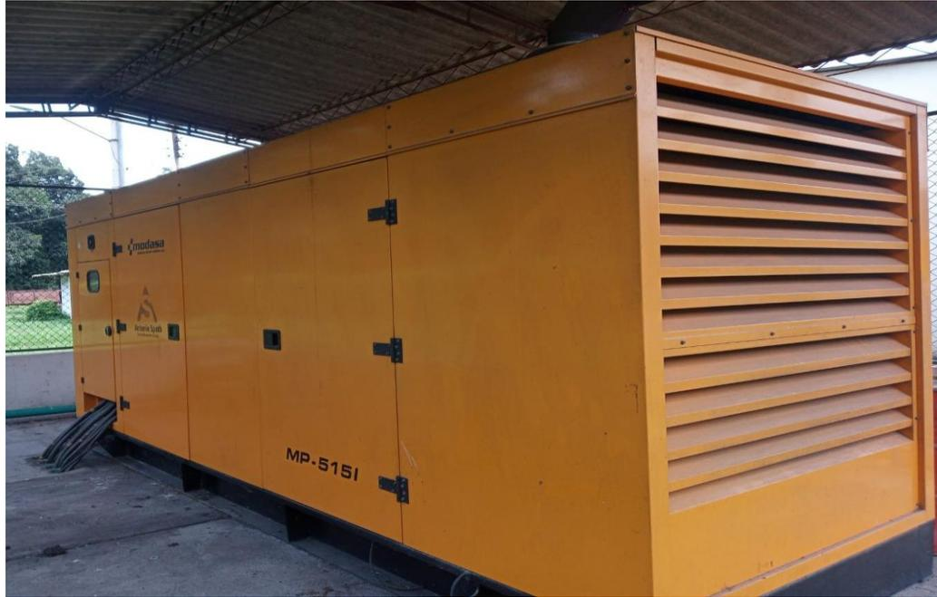
*Figura 12. Planta de emergencia Modasa MP-515I de 625 KVA/500KW- 440V.
