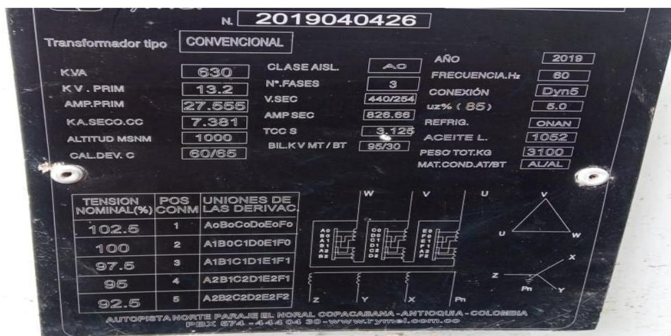
Figura 7. Placa de Características Transformador Trifásico Rymel de 630 KVA 13.2 KV/440-254 V. Fuente Palmacará Ltda.
