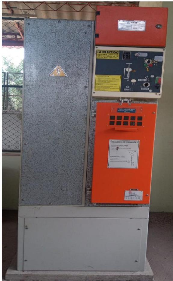
Figura 10. Celda de seccionador bajo carga Sarel. Fuente Palmacará Ltda.
