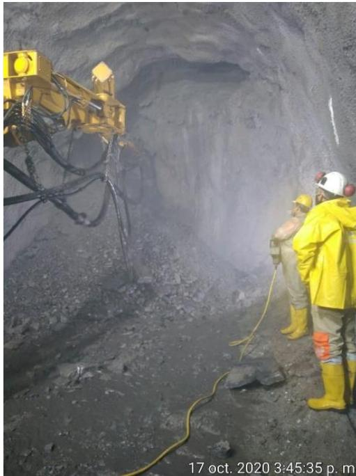
**Figura 39** Manipulación del brazo de proyección por parte del operador
