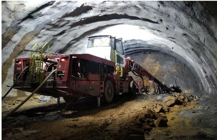
**Figura 34** Jumbo en proceso de barrenación del frente túnel principal
