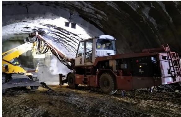
**Figura 20** Equipo de perforación para túneles sandvik DT920i
