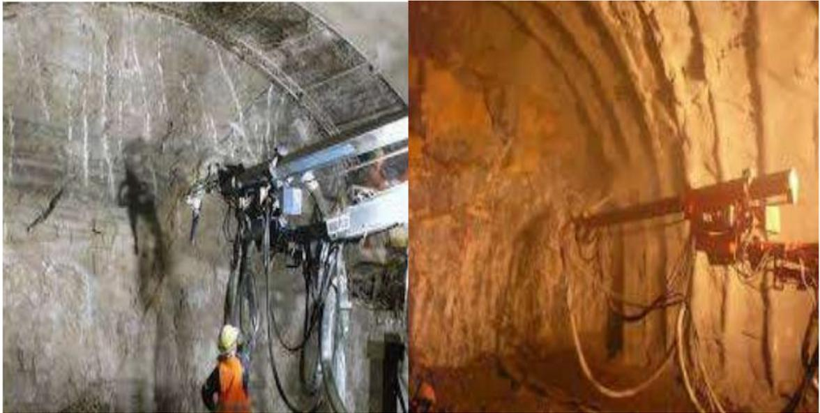
**Figura 5** Aplicación de concreto lanzado
