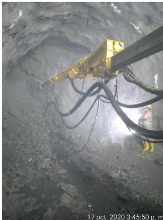
**Figura 41** Operación de brazo de lanzamiento de concreto
