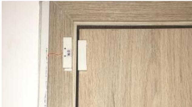
Figura 32. Sensor magnético para el estado de la puerta. Fuente: Autor.
