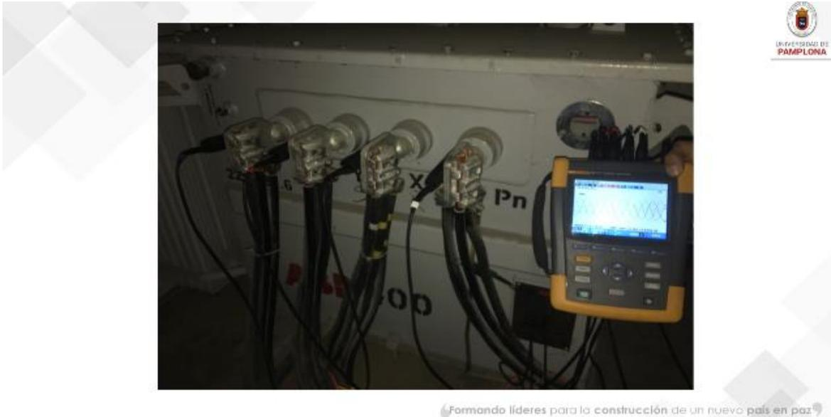
**Ilustración 85.** Instalación y configuración del analizador de redes.
