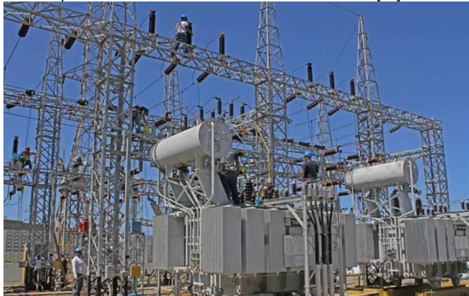
Figura 36. Montaje subestación de distribución. [36]
