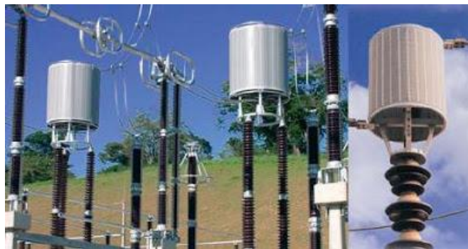
Figura 31. Bobinas de bloqueo. [31]
