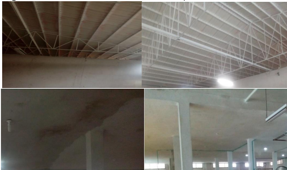
Figura 15. Mantenimiento a techos de la planta
