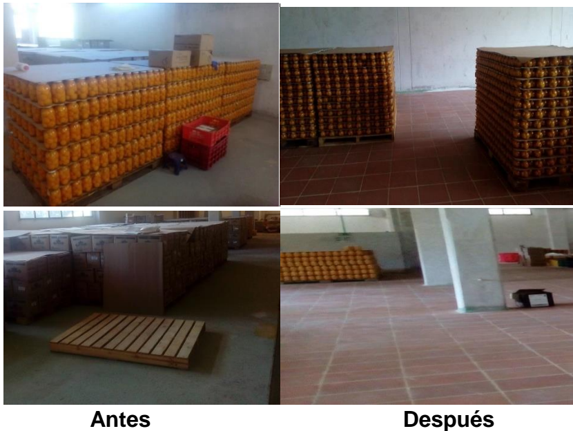
Figura 16. Mantenimiento de piso del área de almacenamiento
