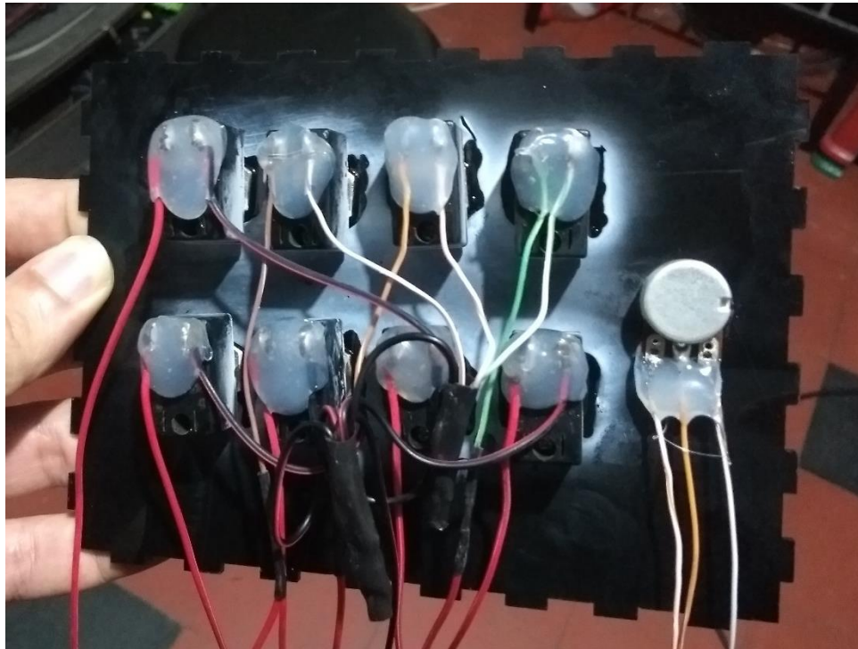
Figura 37. Conexiones internas de la caja para el control de las entradas digitales
