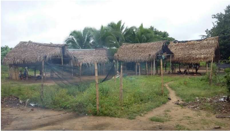
Figura 3. Estructuras de viviendas de la comunidad Genareros. Elaboración propia
