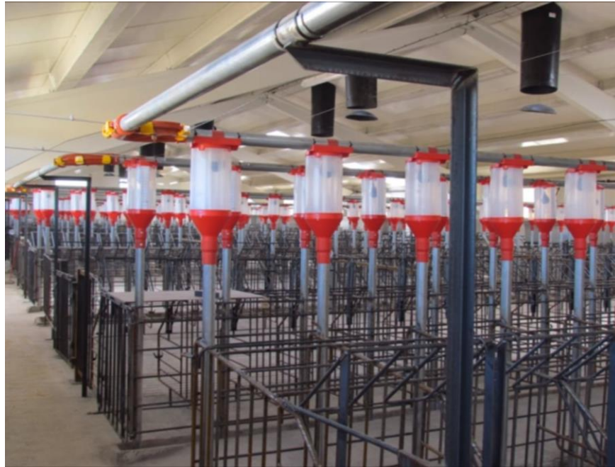
Figura 37: Sistema de distribución de dosificadores [24]
