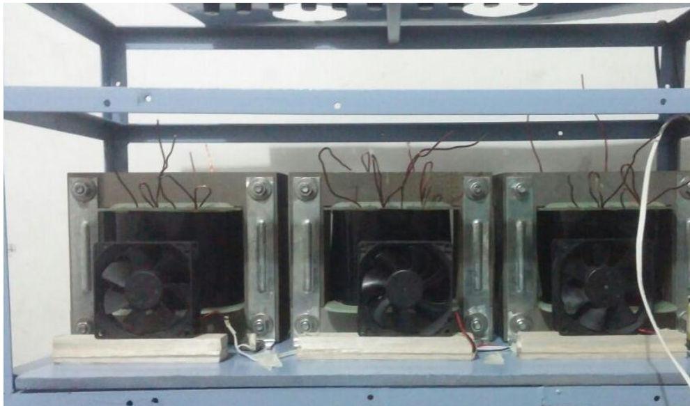
Figura 59. Vista frontal del módulo.
