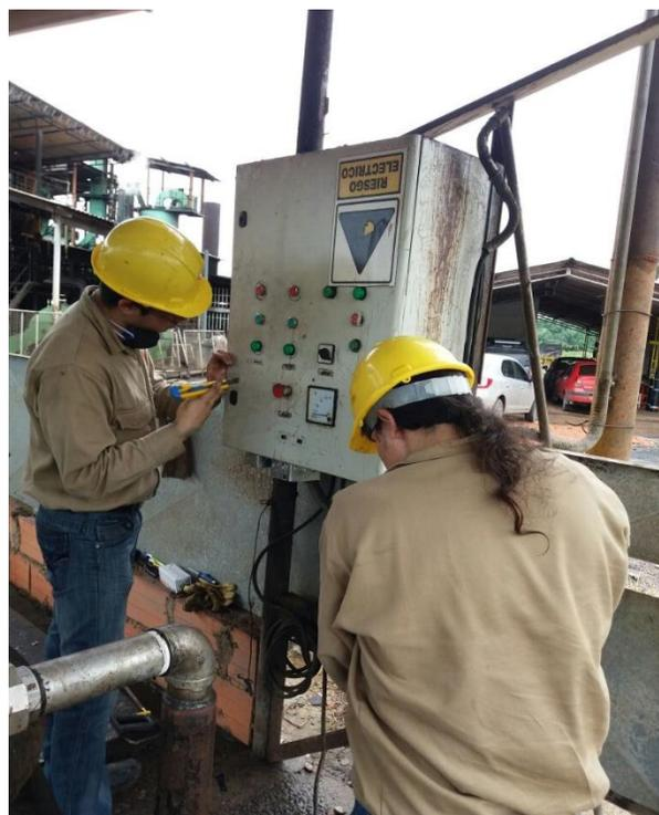
Imagen 43 Limpieza de tablero cárcamo- Equipo desenergizado
