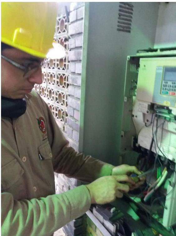
Imagen 42 Limpieza de variador prensa 1-Equipo desenergizado
