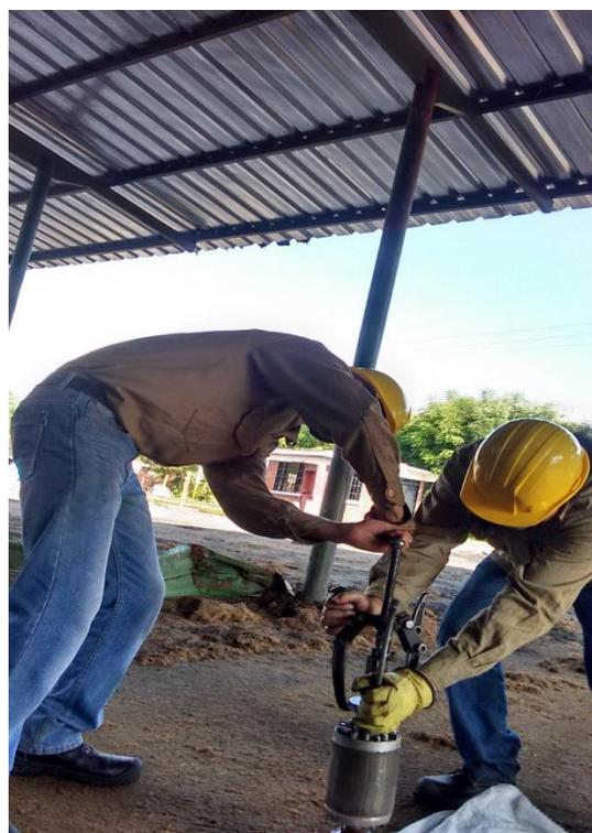
Imagen 44 Extracción de rodamiento motor tiro forzado
