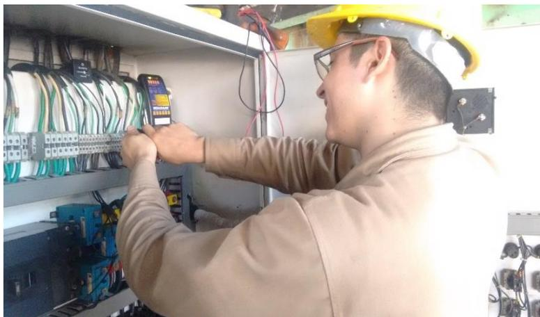
*Imagen 47 Instalación de horometro en tablero de Palmisteria- Equipo desenergizado*
