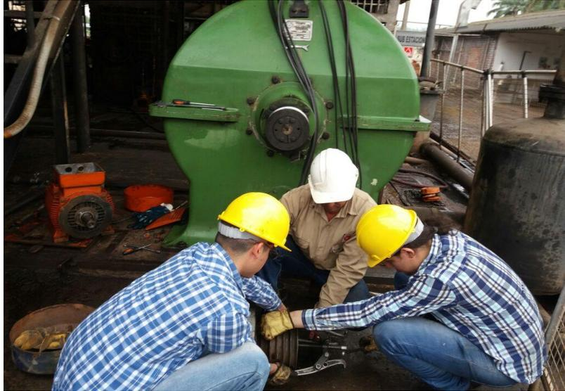
*Imagen 45 Cambio de rodamiento motor centrifuga 2*
