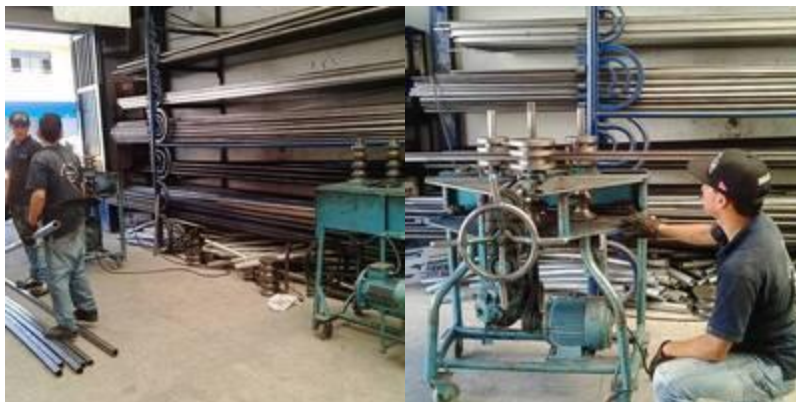
Ilustración 134[Fotografía de Daniela Carrero]. (Bucaramanga. 2018). / Lugar donde se doblaron los tubos para el modelo de comprobación
