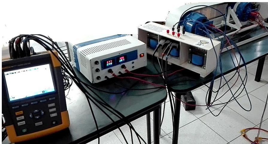
Figura 70. Conexión del analizador red al transformador elevador de la tensión del generador.
