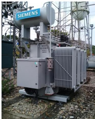
Figura 29. Transformador de 5 MVA Subestación municipio Arauquita.
