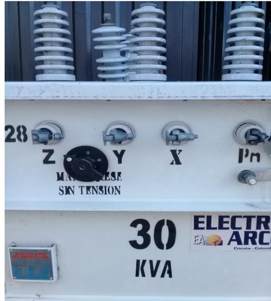
Figura 60. Transformador trifásico de 30 KVA.
