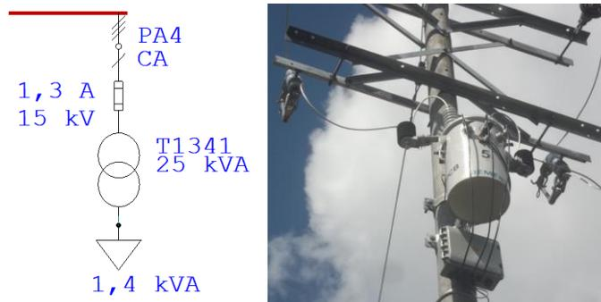
Figura 83. Vista de conexión transformador monofásico.
