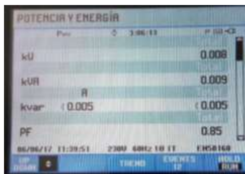
Figura 172 Parámetros de potencia y factor de potencia prueba de cortocircuito realizada en el lado de alta tensión transformador monofásico visualizados a través del analizador de red de marca Fluke
