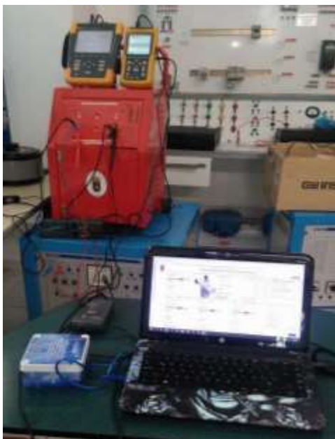
Figura 114 Montaje prueba DC transformador monofásico
