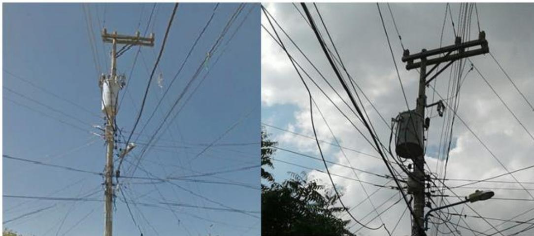
Figura 80 Centro de transformación antes y después de normalizar
