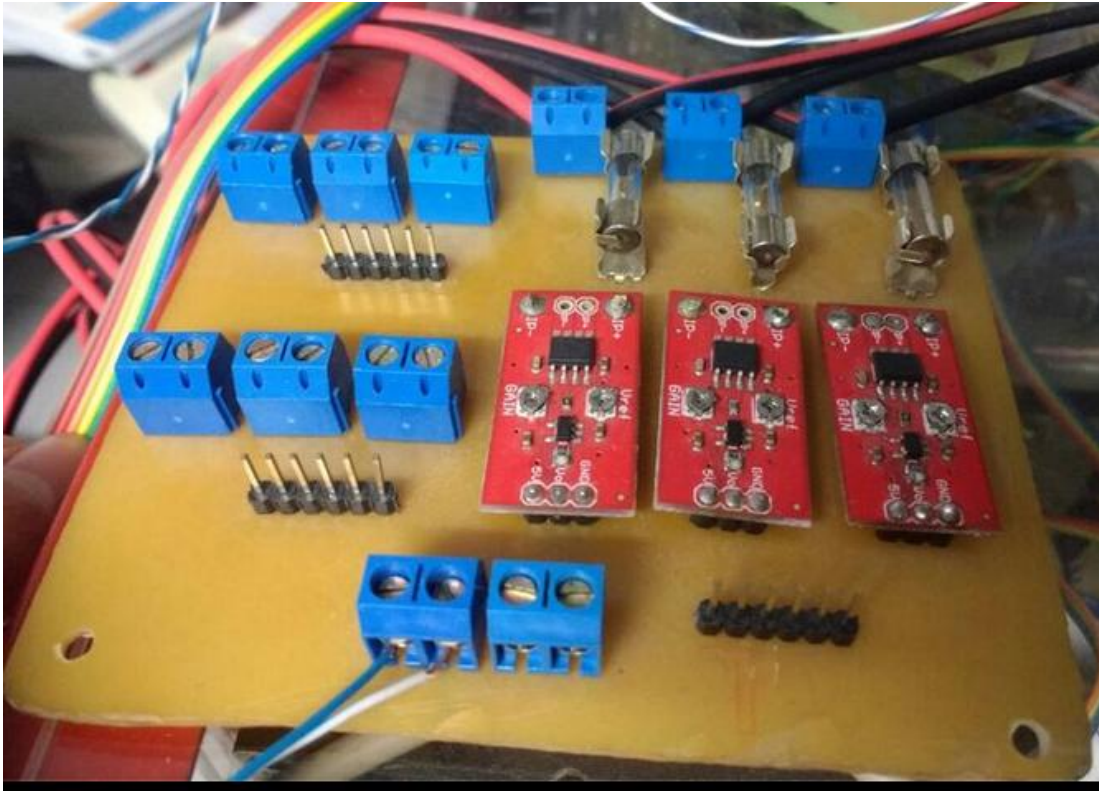
Figura 36. Sensor de corriente ya instalado en baquela.
