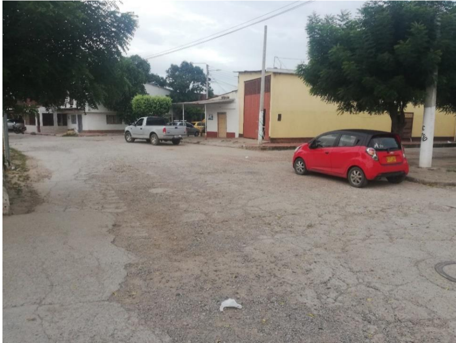
Ilustración 65 Estado de las vías
