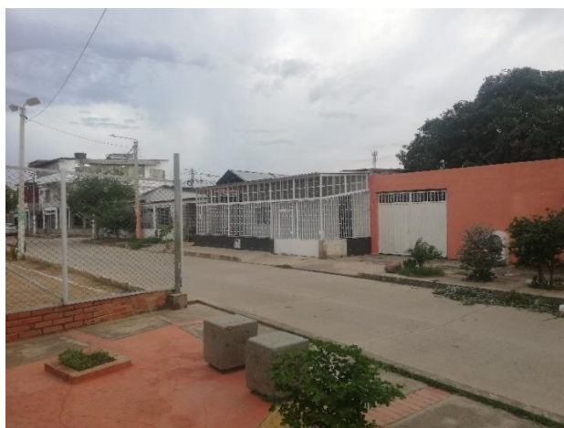
Ilustración 58 Evidencias de andenes en el sector
