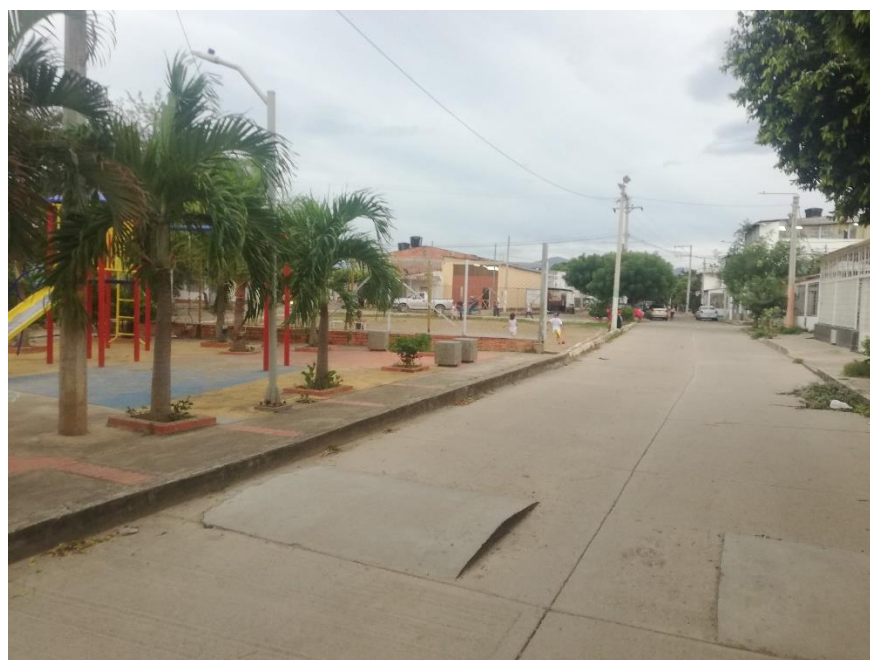
Ilustración 72 Estado de las vías
