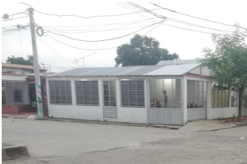
Ilustración 60 Invasión al espacio público sobre el anden
