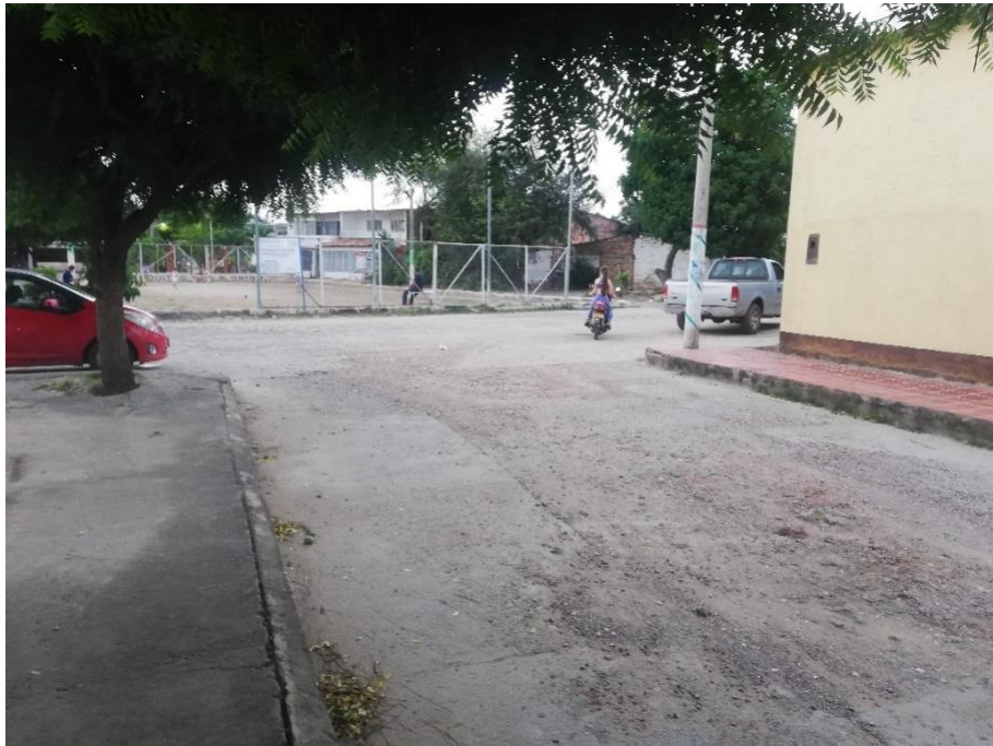
Ilustración 68 Estado de las vías
