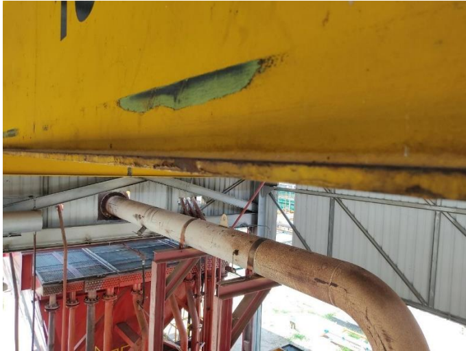
Ilustración 35. Estructura puente grúa
