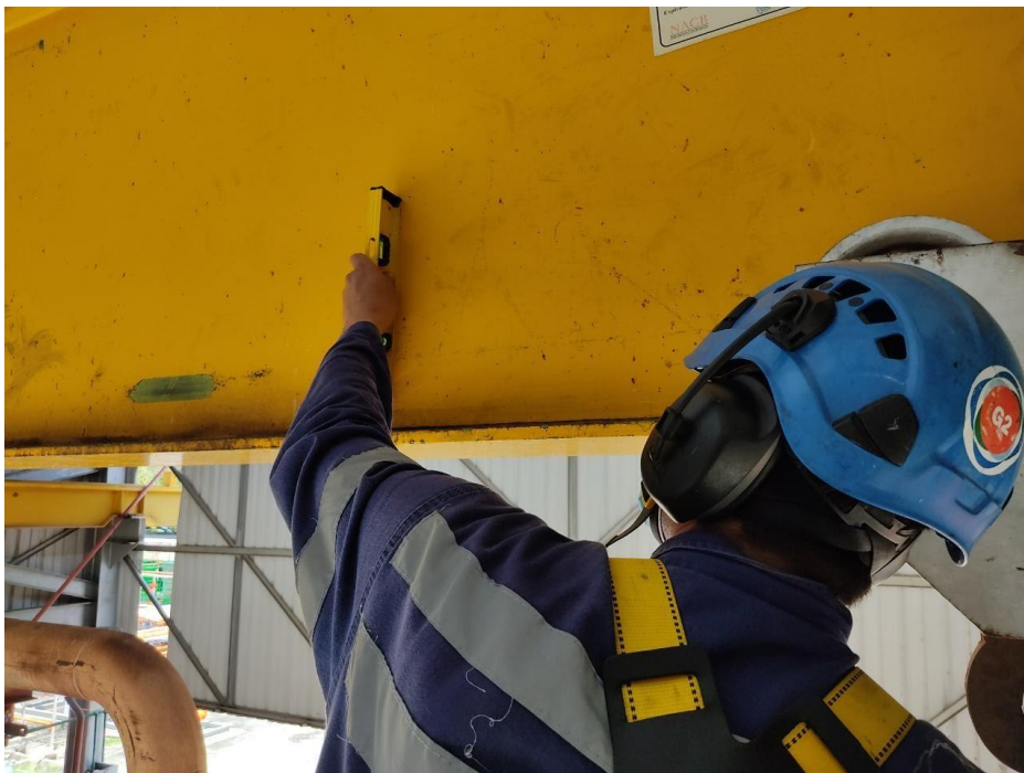
Ilustración 34. Toma de parámetros de abolladuras.
