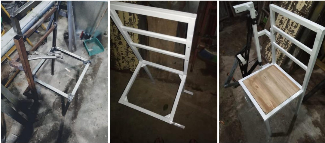
Ilustración 65. Construcción de la silla Fuente: Autor
