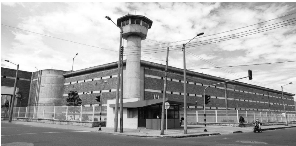
Ilustración 24 Cárcel Distrital de Bogotá
