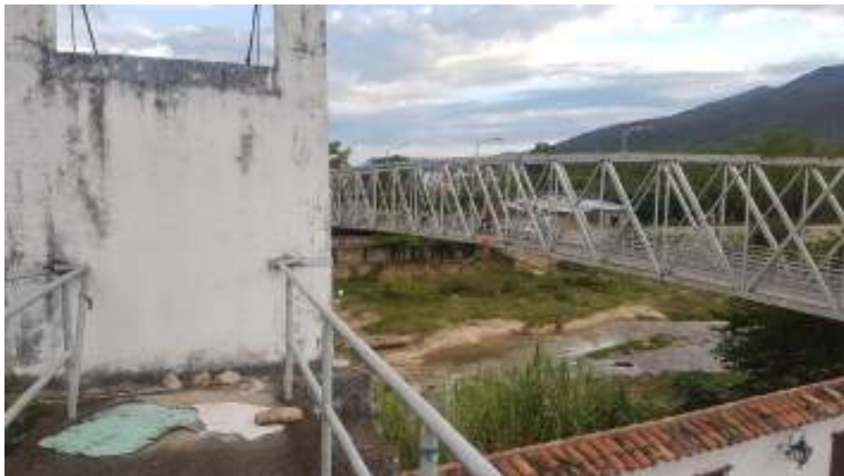
Fotografía: Puentes del Malecón de Girón. Fuente: Elaboración propia.
