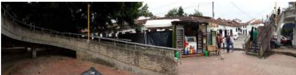
Acceso de las escaleras al puente Rodolfo Gonzales.
