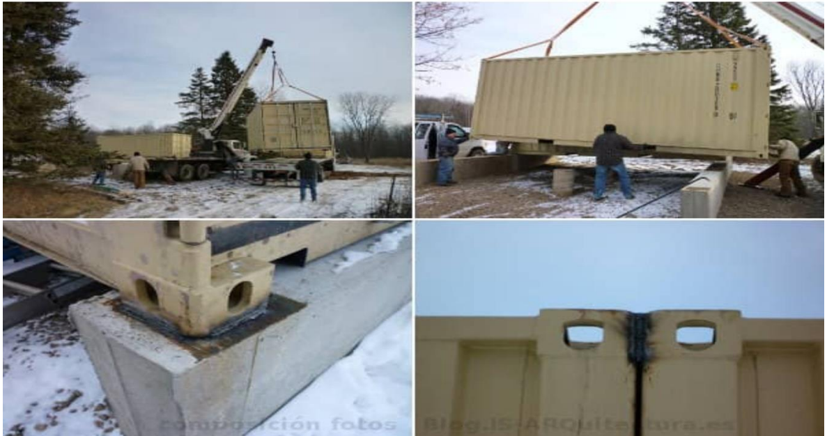
Ilustración 33: Uniones en contenedores de carga marítimos Fuente: Ortiz Michael (2019) a partir revista wed IS-ARquitectura_Prefab
