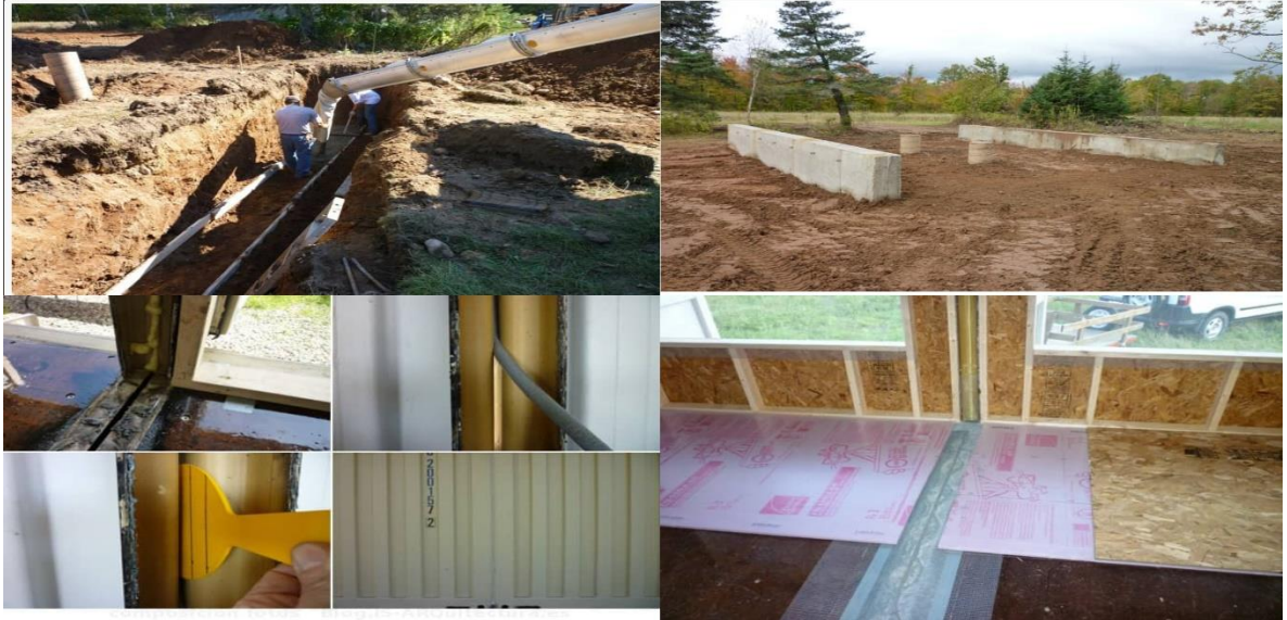
Ilustración 31: Cimientos en contenedores de carga marítimos Fuente: Ortiz Michael (2019) a partir revista wed IS-ARQuitectura_Prefab
