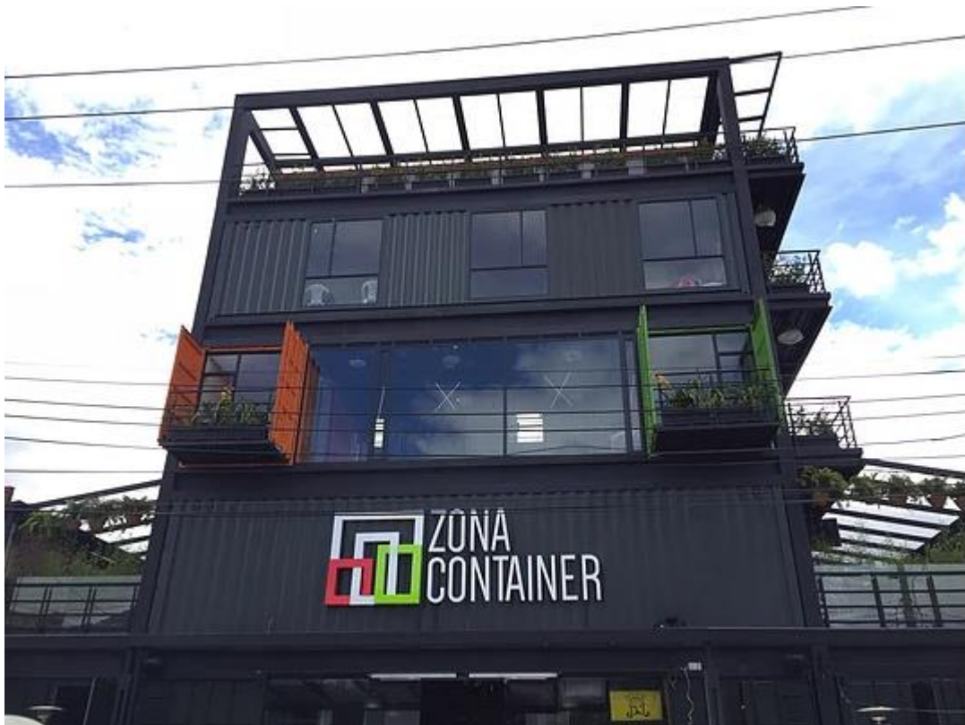
Ilustración 15: ZONA CONTAINER Fuente: Empresa EME Visión Sostenible (2018)
