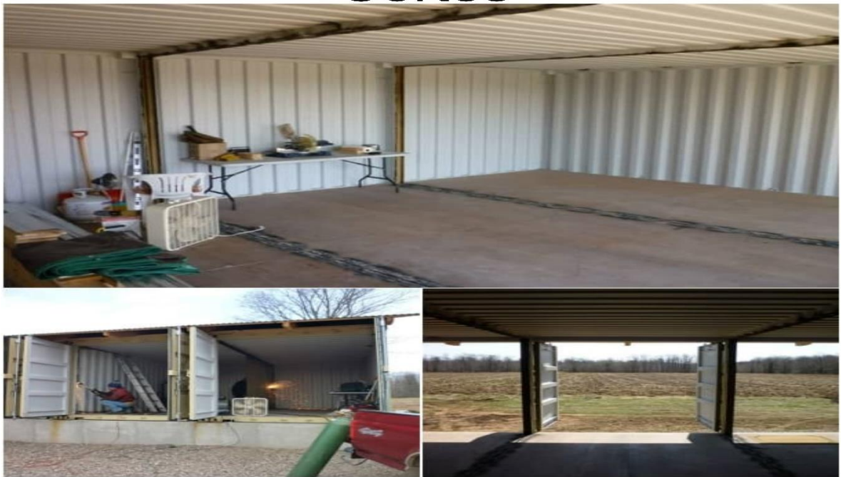
Ilustración 32: Cortes en contenedores de carga marítimos Fuente: Ortiz Michael (2019) a partir revista wed IS-ARQuitectura_Prefab
