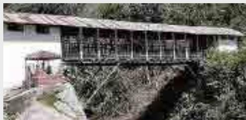
Ilustración N° 087 Puente con cubierta en lamina de zinc, Puente Zulasquilla - Cucutilla
