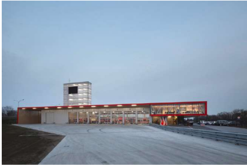
Ilustración 9: Vista exteriores Estación de Bomberos en Puurs Bélgica / Compagnie O Architects
