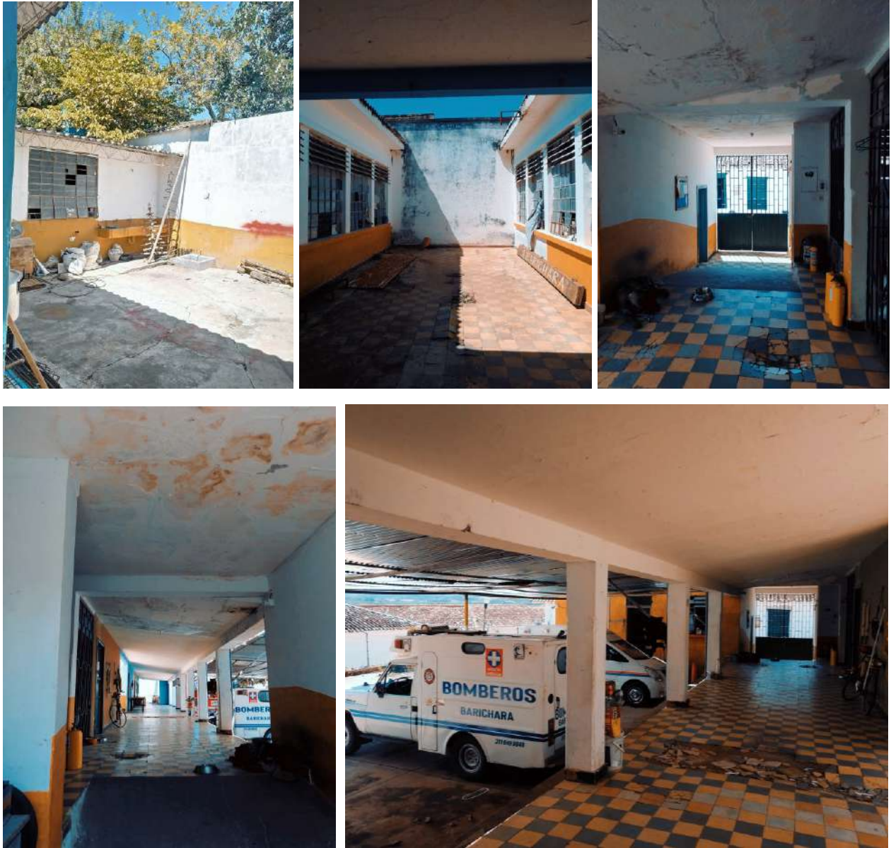
Ilustración 41: Condiciones estación de Bomberos de Barichara.
