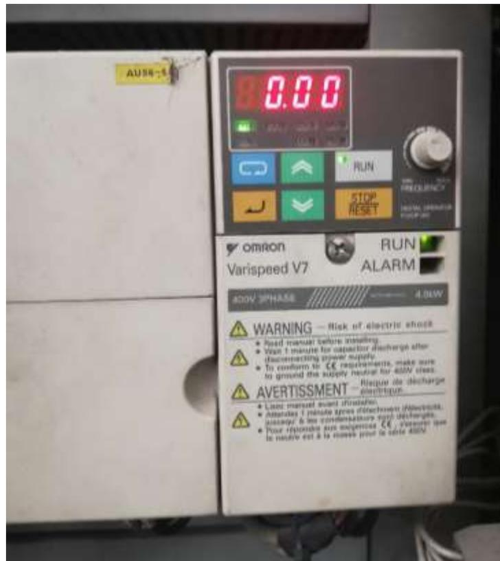
Ilustración 38- Cambio y configuración de variador de velocidad, autor propio.
