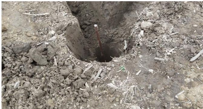
Fig. 60 Zanja para puesta a tierra con su electrodo incrustado. (Autor)
