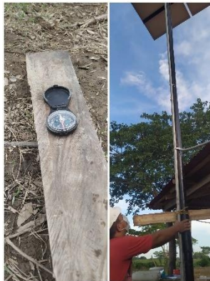
Fig. 56 Brújula para la correcta ubicación de los paneles. (Autor)
