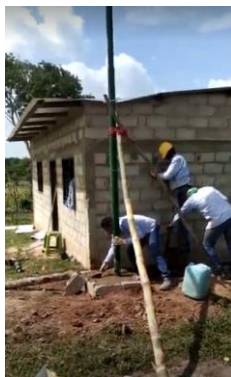
Fig. 91 aplicación de concreto en la base del tubo columna. (Autor)
