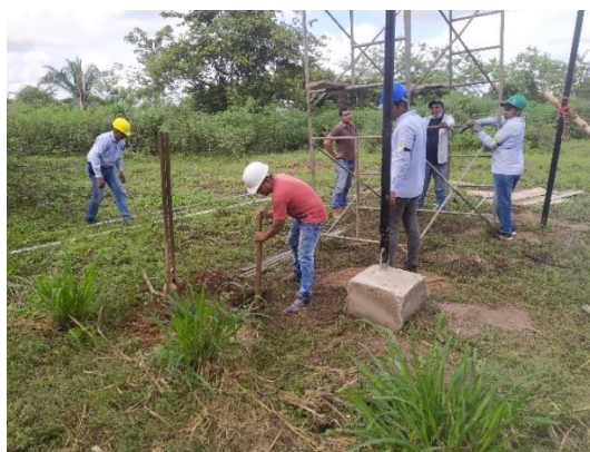
Fig. 116 Cavidad para incrustar la estructura. (Autor)
