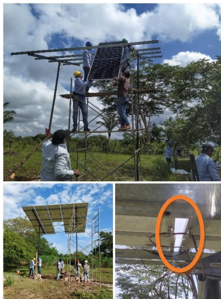
Fig. 117 Ensamble de los paneles a la estructura. (Autor)
