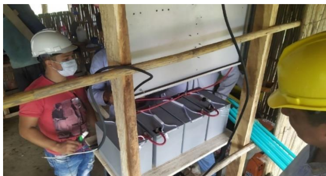
Fig. 58 Conexión de las baterías (serie-paralelo). (Autor)
