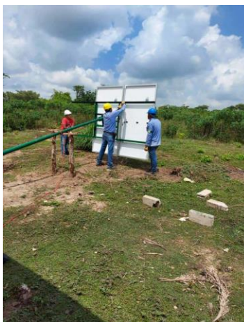
Fig. 86 Conexiones eléctricas de los paneles solares (Paralelo). (Autor)
