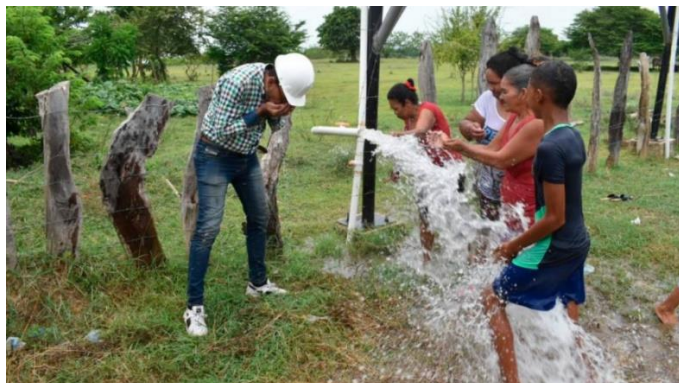
Fig. 24 Acueducto con Energía Solar en el Corregimiento El Cuatro (Municipio de Magangué – Bolívar). [22]
