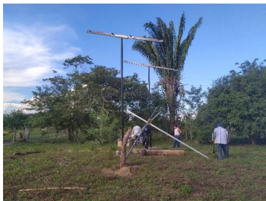
Fig. 115 Posicionamiento de la estructura base de los paneles. (Autor)
