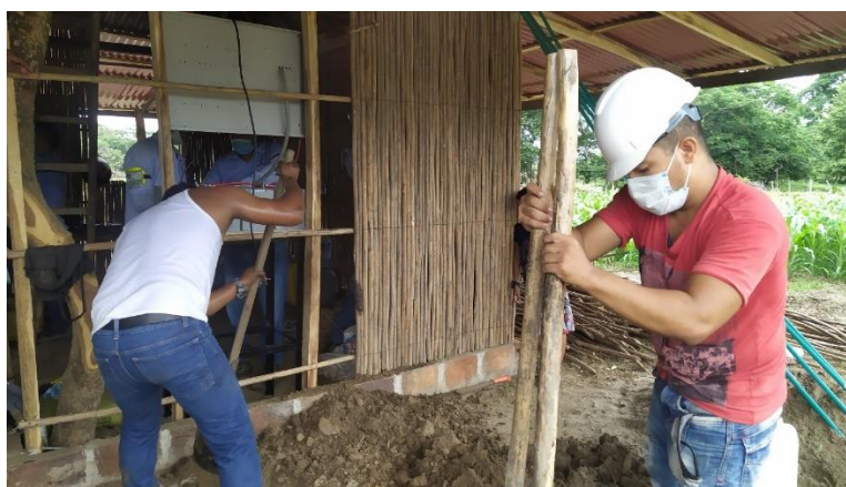
Fig. 51 Cavidad para incrustar la estructura. (Autor)
