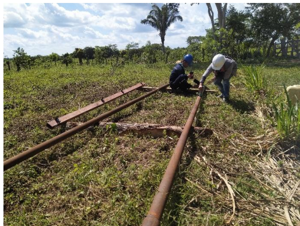
Fig. 102 Estructura pintada con anticorrosivo. (Autor)
