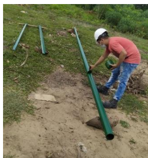
Fig. 74 Aplicación de pintura anticorrosiva a la estructura. (Autor)
