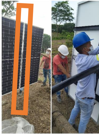
Fig. 54 Ensamble de los paneles a la estructura. (Autor)
