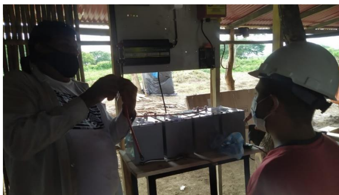
Fig. 59 Conexionando las baterías con el inversor. (Autor)
