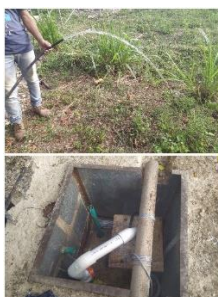
Fig. 122 extracción de agua. (Autor)
