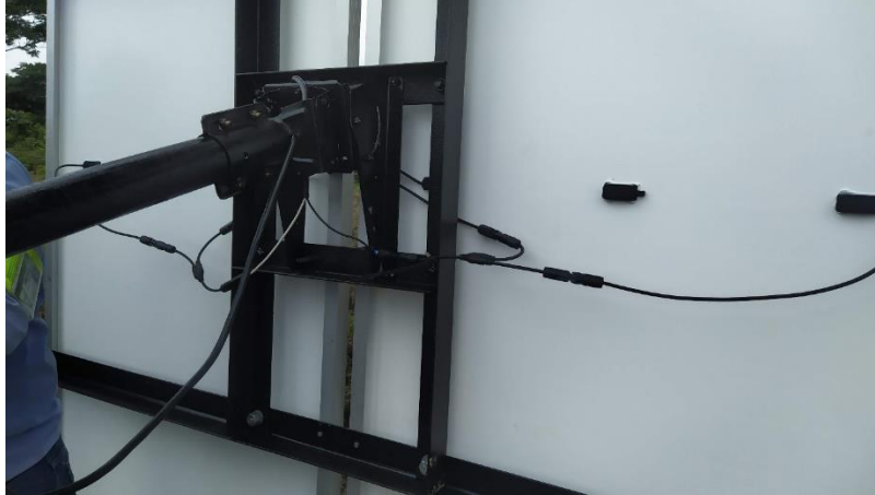
Fig. 53 Conexiones eléctricas de los paneles (Paralelo). (Autor)
