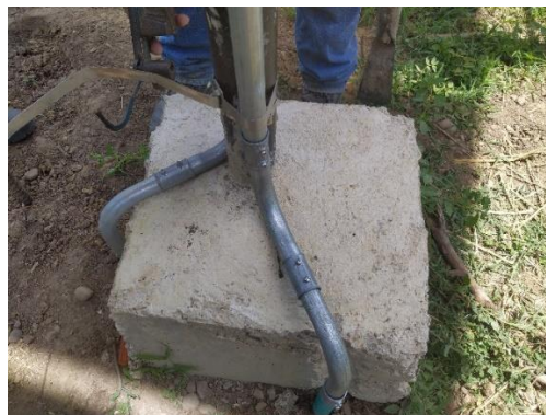
Fig. 119 Zanja para puesta a tierra con su electrodo incrustado. (Autor)
