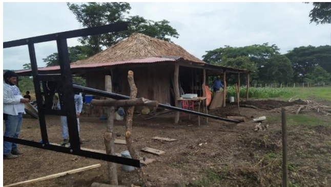
Fig. 39 Ensamble de la estructura base sin los paneles. (Autor)
