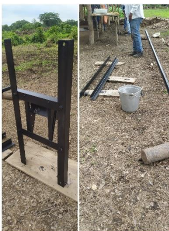
Fig. 36 Estructura pintada con anticorrosivo. (Autor)
