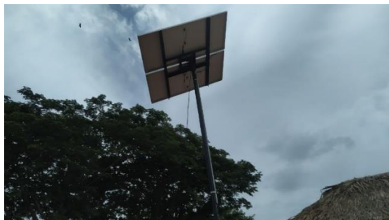
Fig. 55 Estructura de forma vertical con paneles ensamblados. (Autor)
