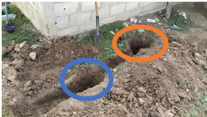
Fig. 84 a). Apertura de la zanja del tubo columna (circulo azul). b). la zanja del SPT (circulo naranja). (Autor)
