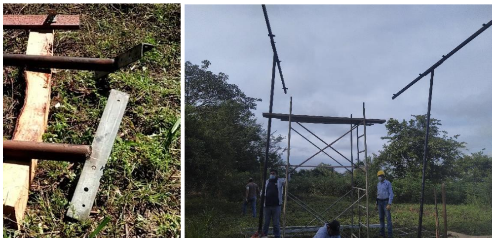
Fig. 104 Ensamble de la estructura base sin los paneles. (Autor)
