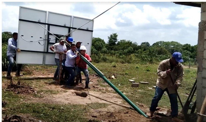
Fig. 88 levantamiento del sistema fotovoltaico. (Autor)
