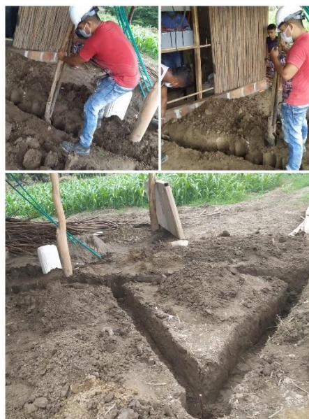
Fig. 62 Elaboración de zanja para el SPT del tablero de mando y el impulsor. (Autor)
