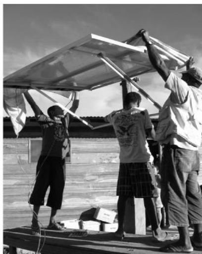
Fig. 20 Montaje de un Sistema Solar Autónomo. [18]
