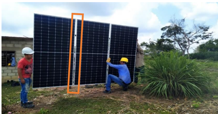
Fig. 87 ensamble total de los paneles solares en la estructura. (Autor)
