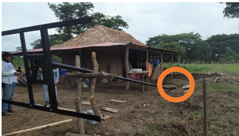
Fig. 50 Posicionamiento de la estructura base de los paneles. (Autor)
