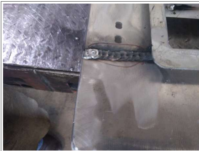
Figura 7.7: Solución aplicación de nueva soldadura. [Autor].
