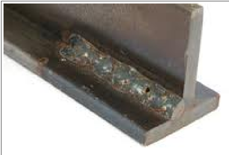
Figura 2.24: Porosidad en cordón de soldadura. [11].
